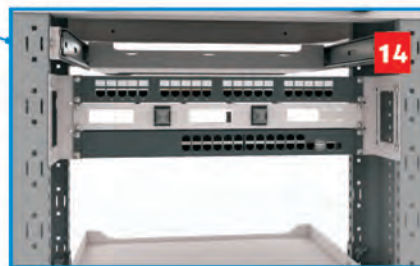
Полезные габариты ящика: ВхШхГ, 60х472х420 мм
