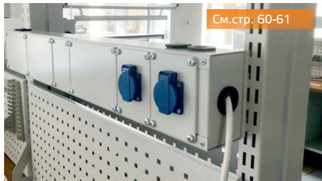
Шины для электропроводки к рабочим панелям
